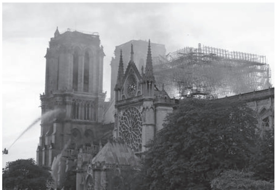
A dos meses del incendio, su restauración está causando más de una pregunta.
